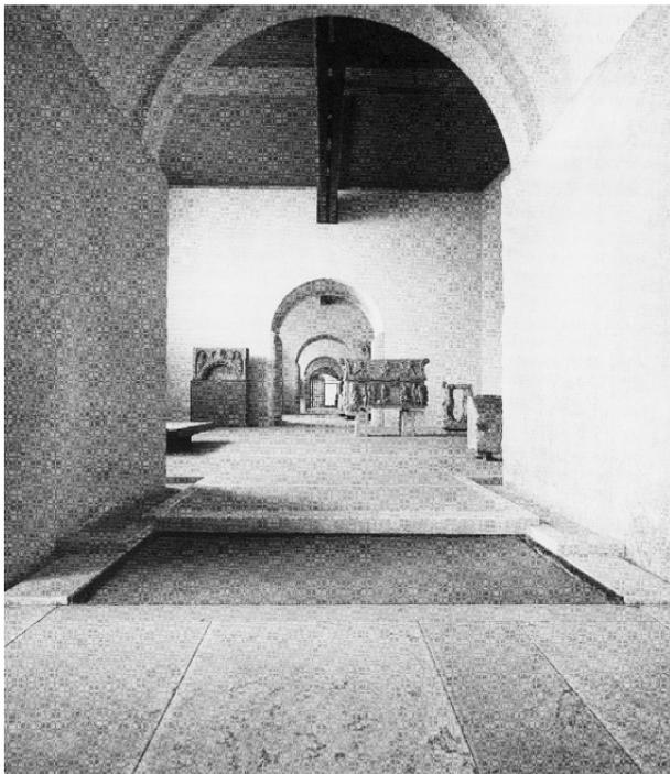
Carlo Scarpa, Museo di Castelvecchio, Verona: la galleria delle sale espositive al piano terra del complesso. La nuova trave in acciaio marca l'asse longitudinale di attraversamento delle sale espositive in successione; il giunto perimetrale in sottogrado media il rapporto tra nuova pavimentazione e muratura antica, risolvendo un nodo tecnico e compositivo-metodologico e integrando il sistema ostensivo
